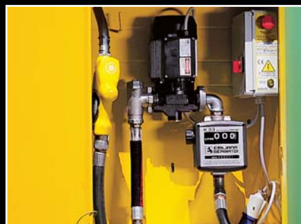
TF/70 (portata 70 lt. min.) Con Elettropompa 230/400 Volt.
